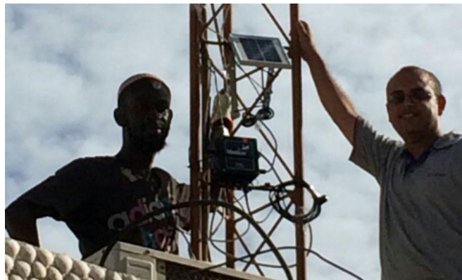
Une antenne-relais érigée au sommet d'un édifice, Sénégal
